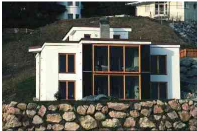
Abbildung 12: Zweifamilienhaus Dämon-List (Foto: Architekt Wehinger) [Ene07]
