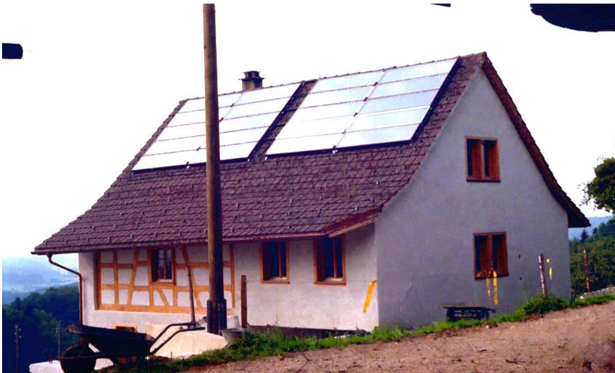
Blick von Süden: Gebäudezustand Juli 2004
